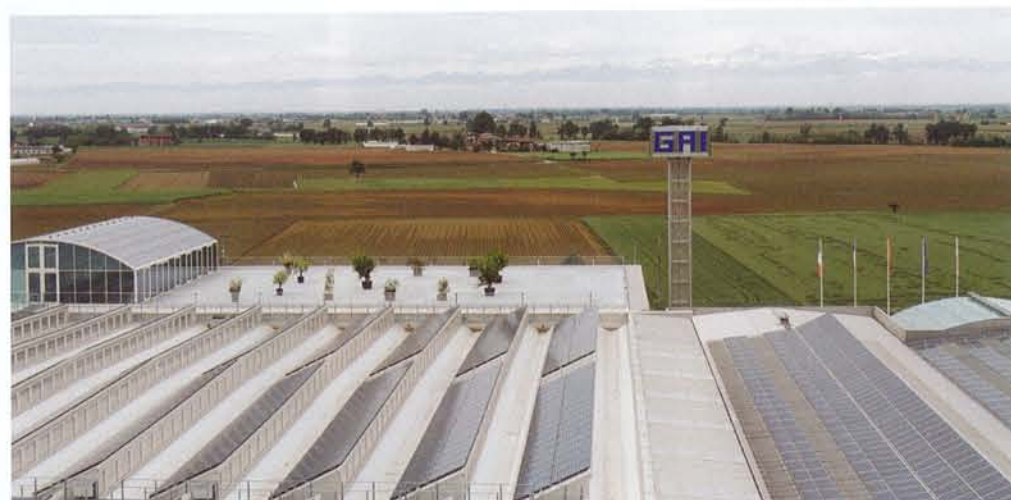
La copertura dei tetti dei capannoni con i pannelli fotovoltaici.
